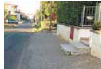
La scalinata che arriva sulla strada
